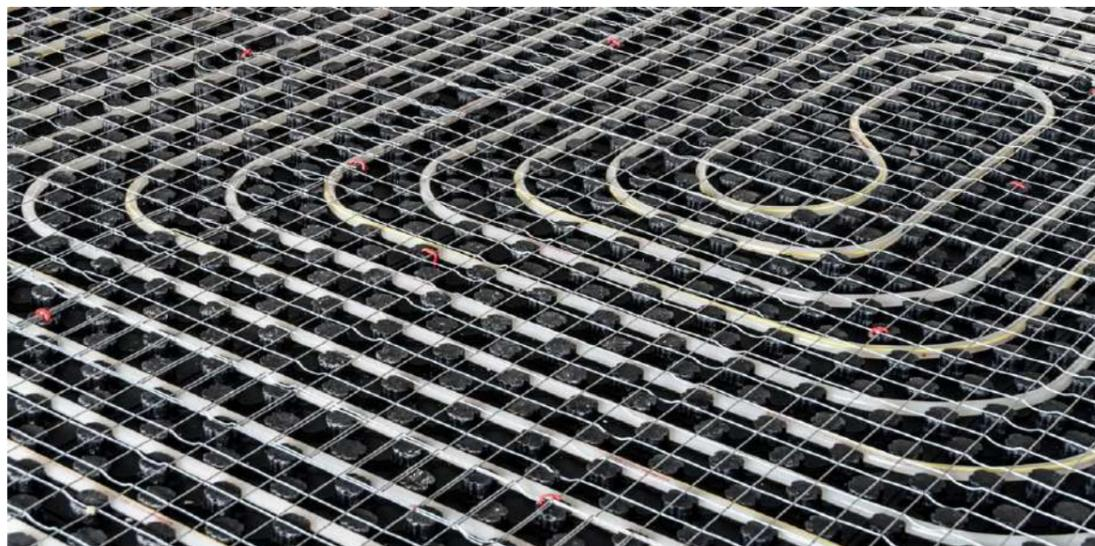
Gli impianti a pannelli radianti per riscaldamento sono in grado di coniugare un elevato livello di comfort con un notevole risparmio energetico. Gli elementi radianti, costituiti da tubi in materiale resistente alle temperature ed al calpestio, vengono inseriti sotto il pavimento.
